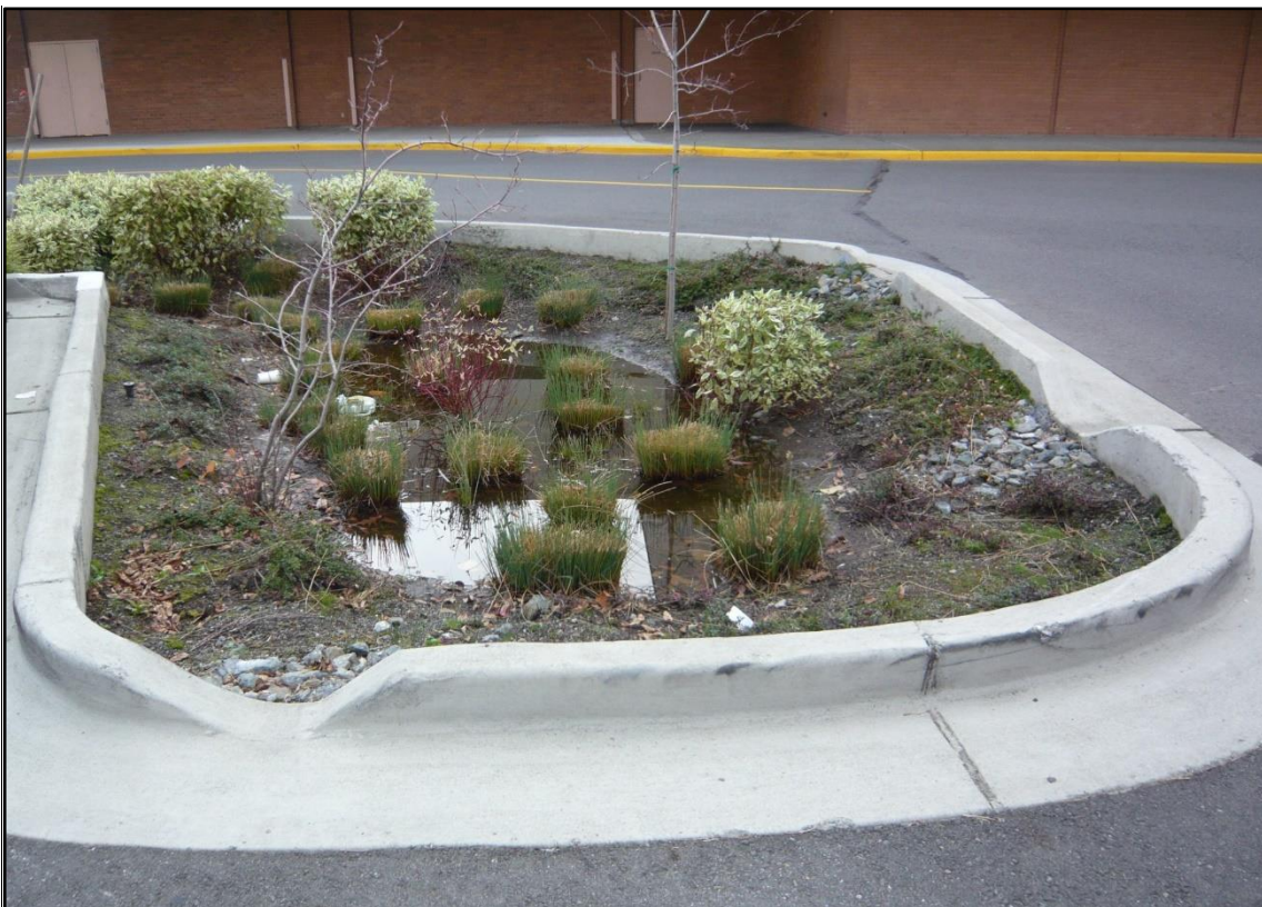
Kuva 13 Esimerkki hulevesipainanteesta Seattlessa (FCG, 2011)
